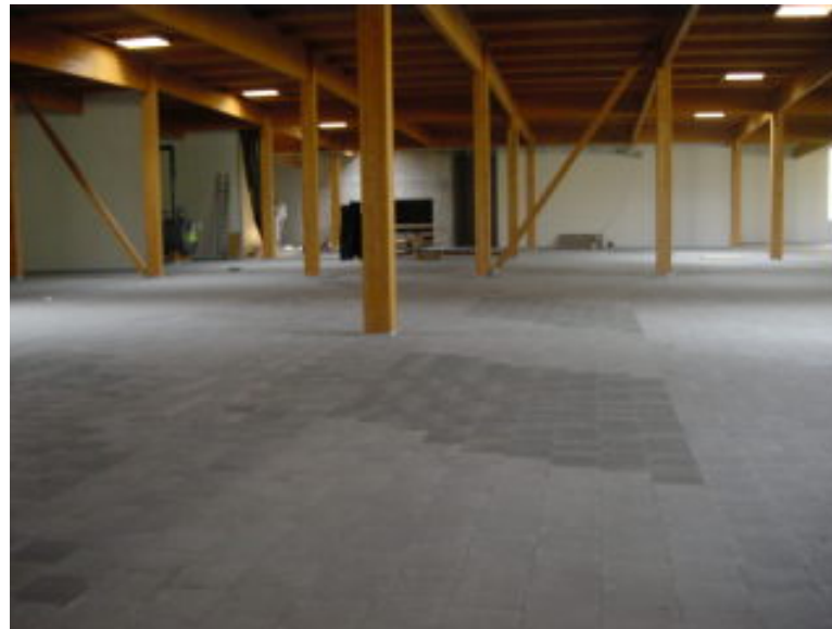
BEST Trockenstrich in einer industriell genutzten Halle.
