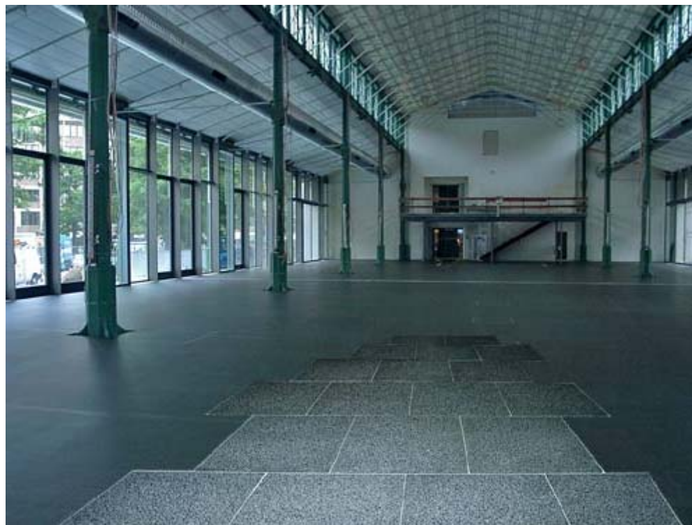
Verlegung als Hohlrumboden in der Schrammehalle München. Fläche zusätzlich als Nutzboden ausgeführt.
