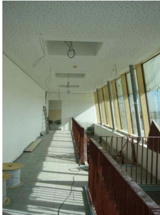
Trockenestrich verlegt in einer Schule.
