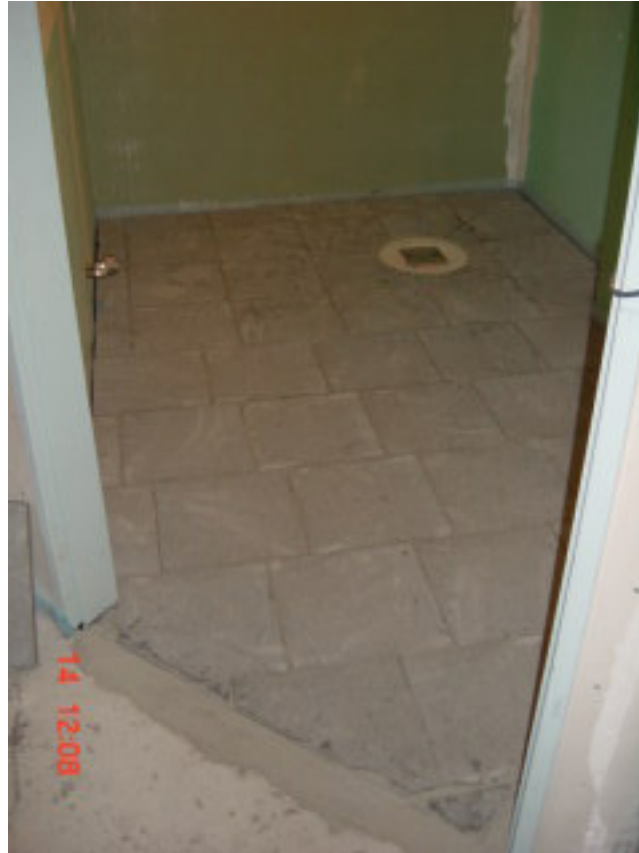
Sanierung eines Pflegeheims, Ausführung bodengleiche Dusche.
